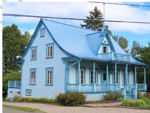
Le 265, rue Principale Est.
