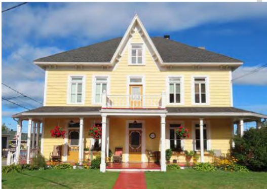
Le 259, rue Principale Est.
