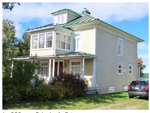
Le 283, rue Principale Est.
